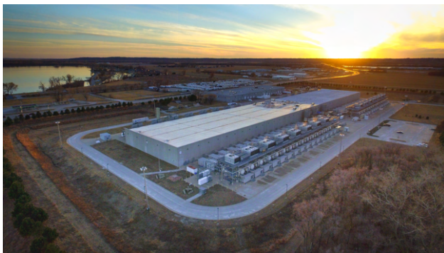
Figura 4: Vista aerea del data center di Google a Council Bluffs, IA 26
